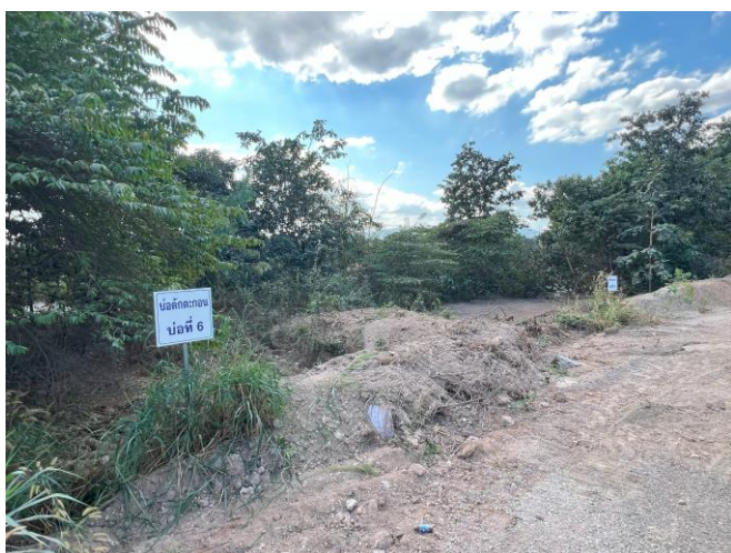
รูปที่ 2-8 บ่อดักตะกอนเพื่อรองรับรับชะล้างตามแนวเขตในพื้นที่เว้นการทำเหมือง ระยะ 10 เมตร
