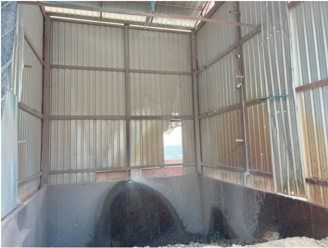
รูปที่ 2-22 ก. (ต่อ) โรงโม่หินที่เป็นระบบปิด และมีการติดตั้งระบบสเปรย์น้ำ
